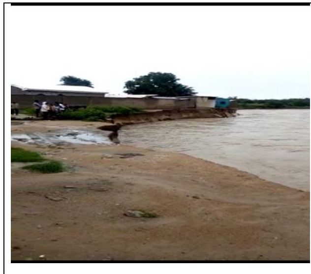
Figure 120: Les inondations ont frappé Mayo Kaliao (Maroua), emportant une partie des terres le 6 août 2019
