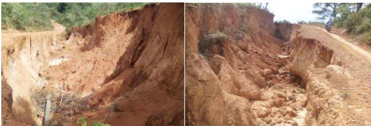
*Figure 115: dégradation du tronçon routier Lip-Mbokam, arrondissement de Jakiri, département de Bui, région du Nord-Ouest, en août 2020.*
