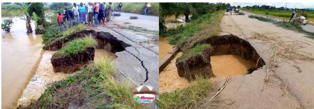
Figure 117: dégradation et destruction du tronçon routier de Santchou et Melon suite aux fortes averses du 21/08/2020.
